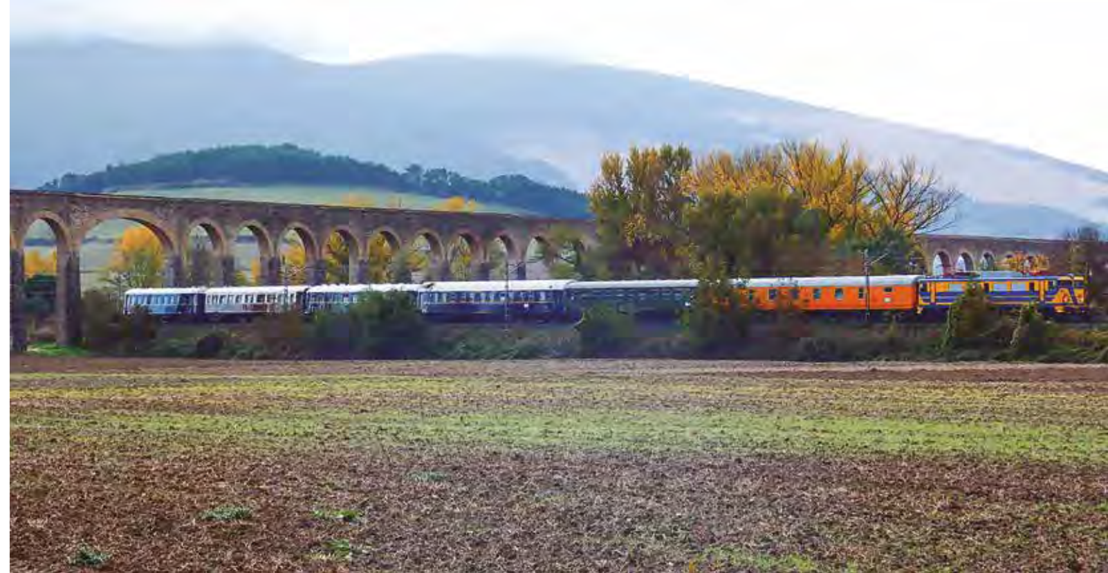
La 269-324 con el tren azul efectúa su paso por el acueducto de Noáin rumbo a Pamplona
